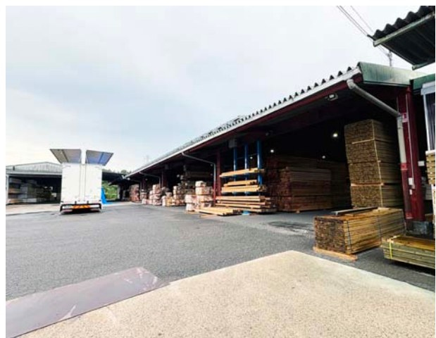
3棟の倉庫で加工済み製品を管理している
