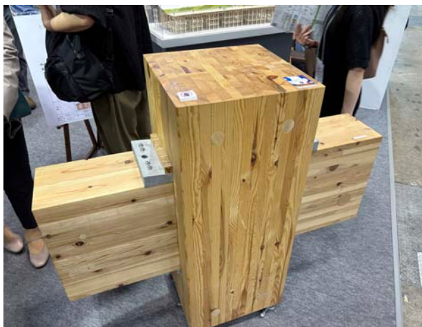
大阪万博の大屋根リング（接合部のモックアップ）
