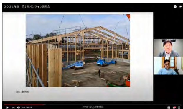
ATAハイブリッド構法を用いたスパン33mの店舗
