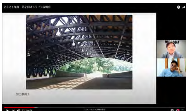
スパン23mの大空間を実現させたアーチ構造の建物
