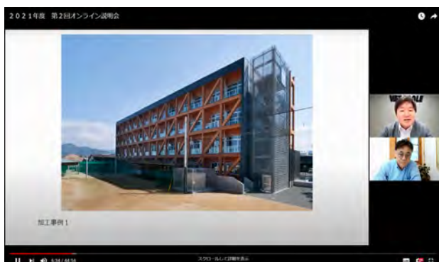
270mm×360mmの大断面材を用いた校舎
