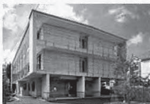
耐火木造3階建て福祉施設
