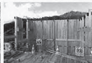
CLT+集成材軸組工法
