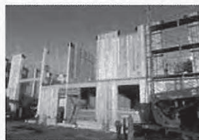
CLTパネル工法
